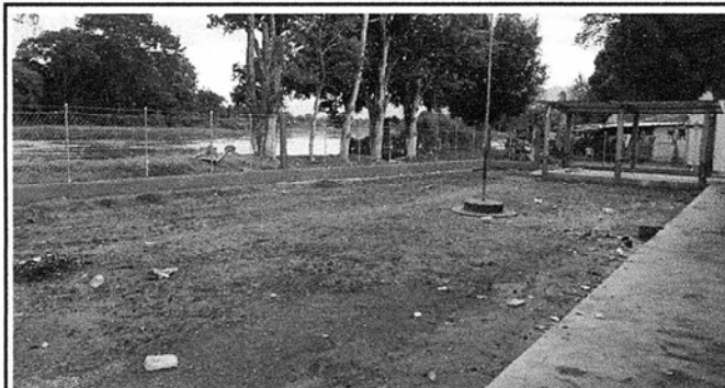
FOTO 6: SE OBSERVA LA CULMINACIÓN DE LA COLOCACIÓN DE MALLA GALVANIZADA
