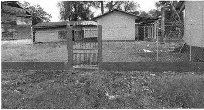
FOTO 7: SE OBSERVA LA CULMINACIÓN DE LA INSTALACIÓN DE PORTÓN DE METAL
