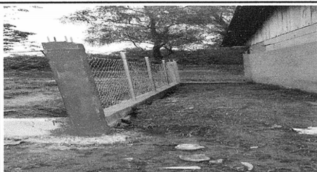
FOTO 5: SE OBSERVA LA CULMINACIÓN DE LA COLOCACIÓN DE MALLA GALVANIZADA
