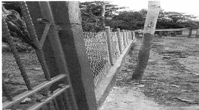
FOTO 1: SE OBSERVA LA CULMINACIÓN DEL LEVANTAMIENTO DE MURO PERIMETRAL
